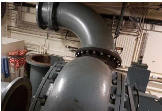
Отвод 90°, машинное отделение – Права на иллюстрацию: компания «bremenports GmbH & Co. KG»
