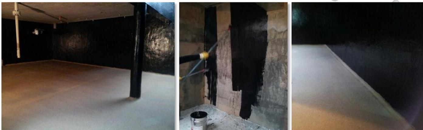
В качестве химически стойкого высокотехнологичного покрытия всех поверхностей применен материал **Proguard CN-1M**, нанесенный одним слоем с помощью валиков.
