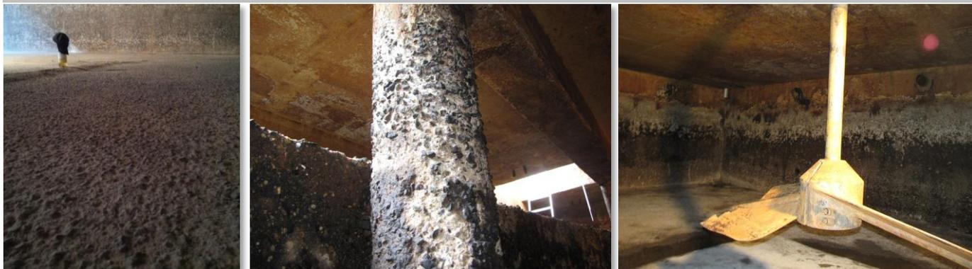
Из-за сильных повреждений, вызванных химическим воздействием агрессивных биохимических отходов, бетон находился в очень плохом состоянии.
