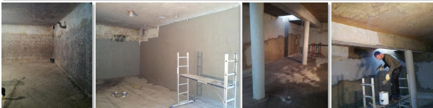
Сначала все поверхности были подвергнуты основательной пескоструйной обработке. Кроме этого, на стены была нанесена высококачественная грунтовка и шпаклевка. Поврежденные поверхности бетонных колонн также были обработаны специальным раствором. После такой подготовки стены были обработаны нашим праймером **CP-Synthofloor Beta 8016**, обладающим высокой устойчивостью к действию химических веществ и износостойкостью.
